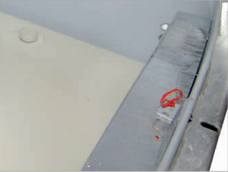
Peilstab für Leckagekontrolle
