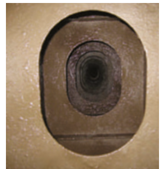
Zweite Schicht - PERMA FILM Buff mit 250 µm (wff.)
