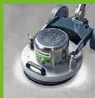
Aufarbeiten und Schleifen von Estrichböden
