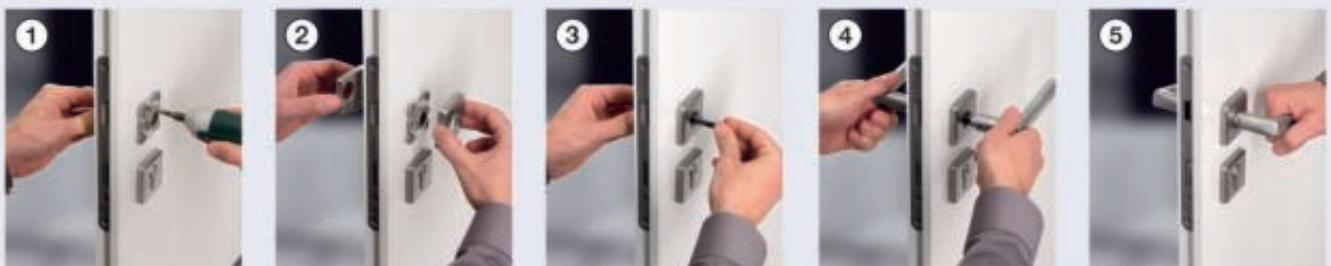
1 Unterkonstruktion aufstecken und festschrauben
