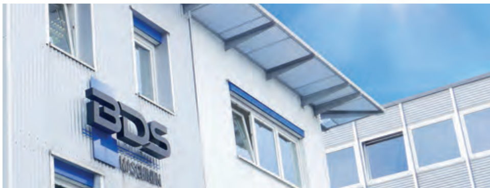
BDS-Firmenzentrale und Fertigung in Mönchengladbach
